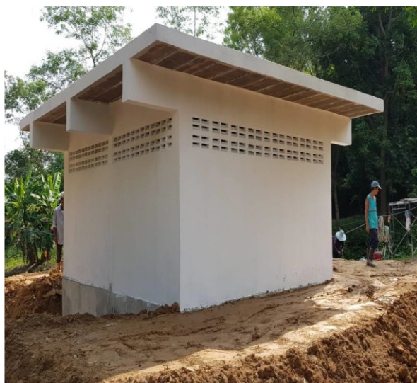
งานอาคาร Control House
