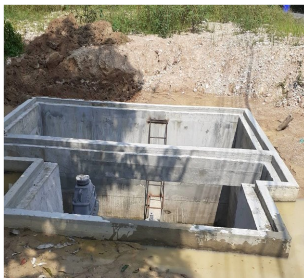
งานอาคารท่อแยก
